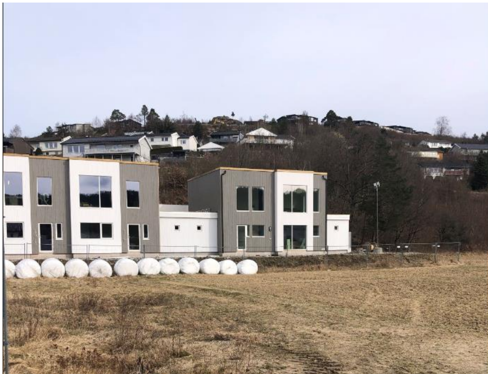
Figur 3: Eksempel på manglende buffersone mellom dyrka mark og boligbebyggelse.
